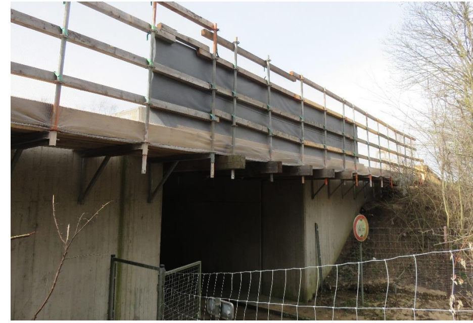
Abbildung 1: Gerüst zur Erneuerung der Außenkappen.
