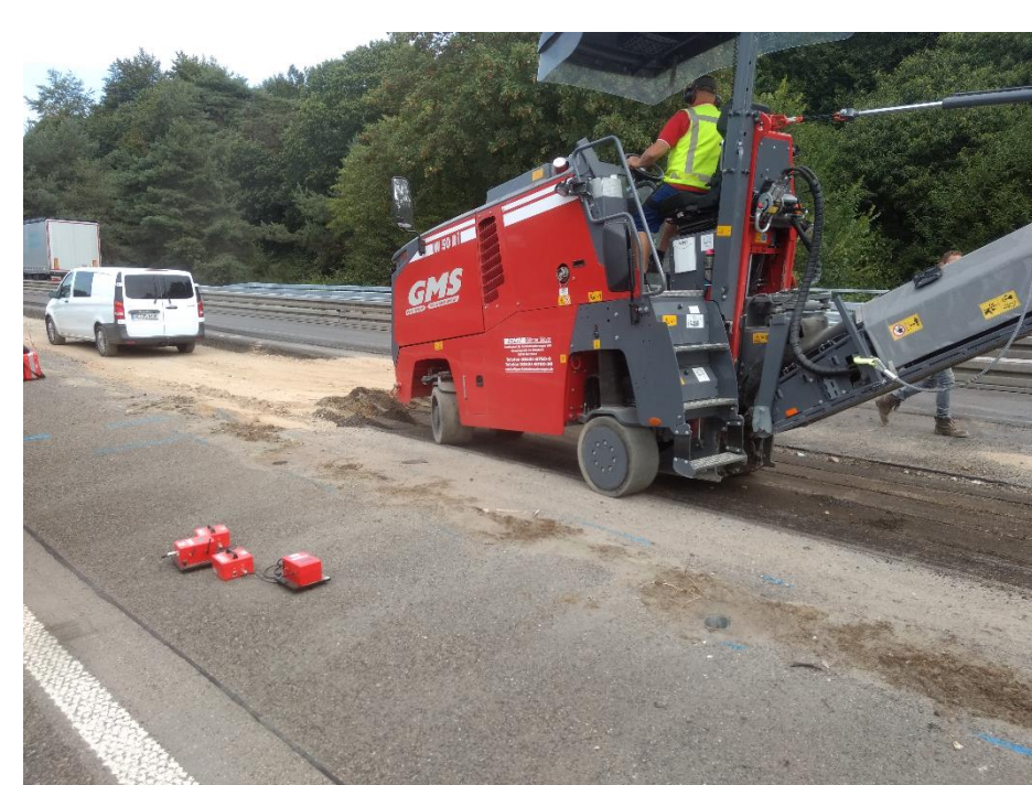
Abbildung 4: Beurteilung der Arbeiten, Erschütterungsmessung während der Fräsarbeiten.
