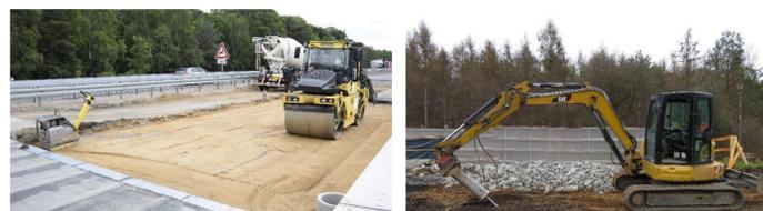
Abbildung 3-4: Begleitete Arbeiten ohne vergrämende Wirkung der Tiere im Bauwerk: Linkes Bild: Rüttelplatte sowie Walze mit Vibrationsverdichtung, rechtes Bild: Bagger mit Stemmeißel.
